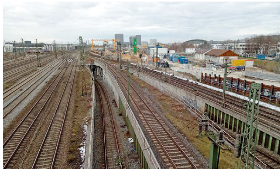
1: Bauinstallation 2. S-Bahn-Stammstrecke an der Donnersbergerbrücke
